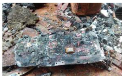
Foto nr.5 - Cabina de conducere II - Stația RTF
