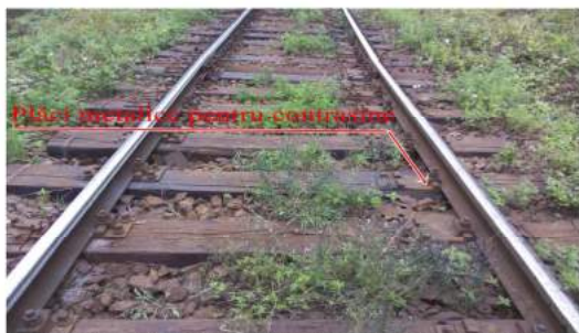
Foto 4- Plăci metalice speciale pentru contrașine montate pe firul interior al curbei
